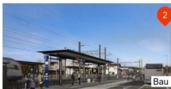
U5 Bahnhof Rothenburg Station als Verkehrsdrehscheibe ausgestalten
