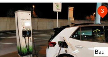
U17 Erstellung von E-Ladeinfrastruktur Auto bei öffentlichen Parkplätzen
